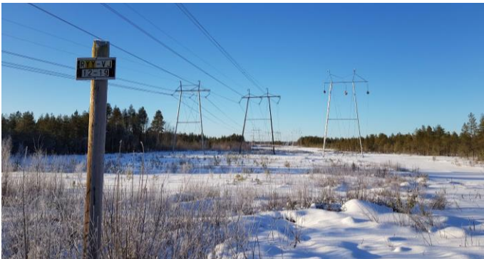
Sähköasema ja voimalinjat Humpinmäentieltä avautuvissa näkymissä.
